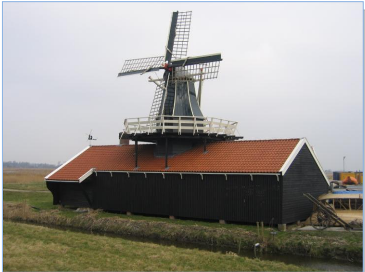
'De Corneliszoon', een windmotor met een vlucht (lengte van de roede) van 10 meter
