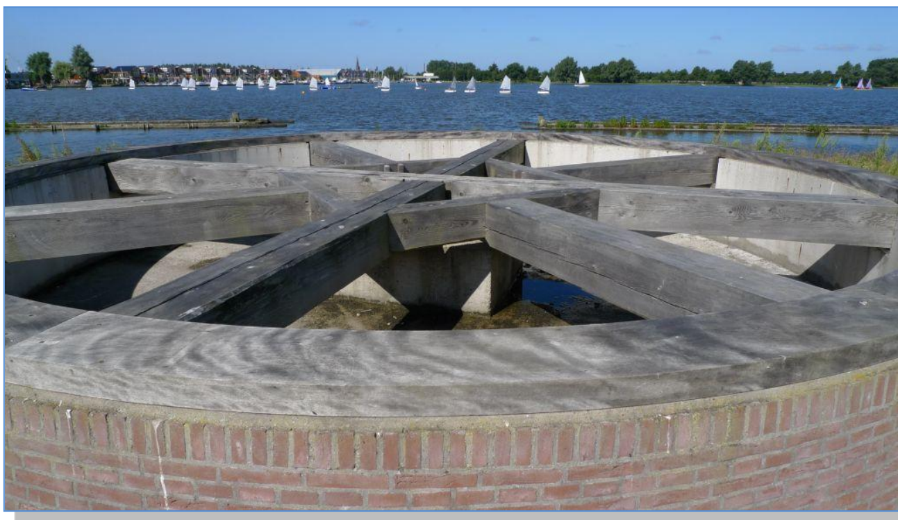
De reeds aanwezige molenfundering met zwaarden, kruishouten en kruivloer.
