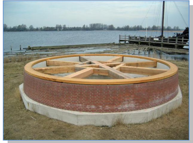
Ringmuur met zwaarden, kruisbalken en kruivloer
