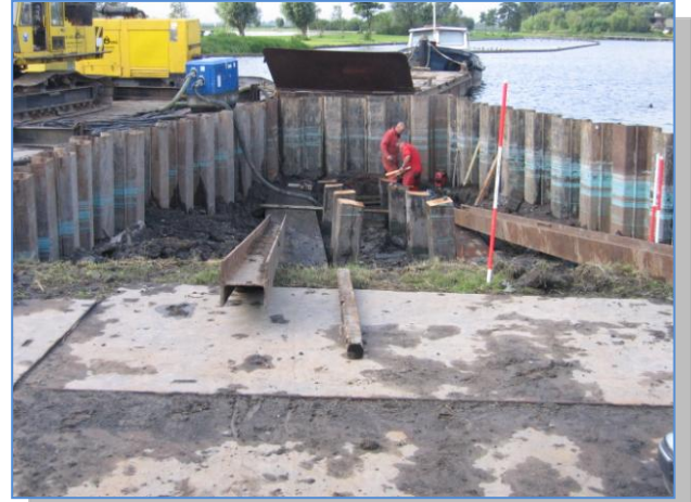
De scheepshelling in aanbouw. De basis van de helling voldoet aan de geldende milieu-eisen.
